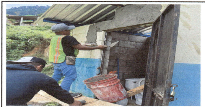
Foto 5: REPACION DE BAJADA PLUVIAL Y CERNIDO DE PARED EXTERIOR
