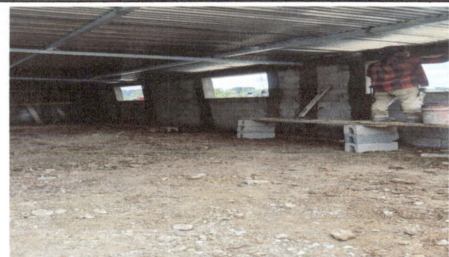
Foto 3: REPARACIÓN DE PARED Y PISO
