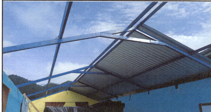
Foto 2: CAMBIO DE LÁMINAS A LÁMINAS TROQUELADAS
