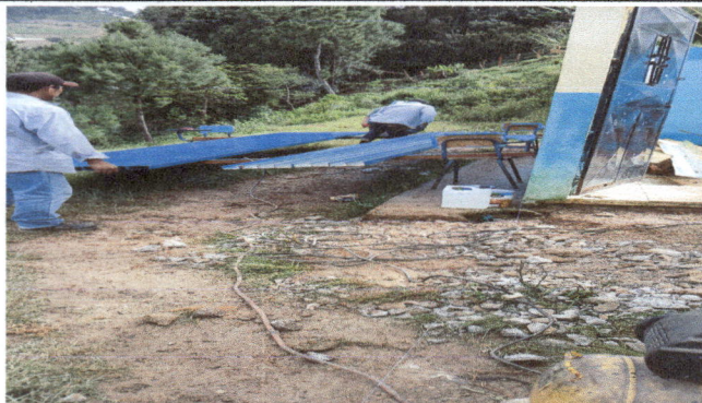
Foto1: CAMBIO DE ESTRUCTURA DE TECHO DE MADERA A METAL
